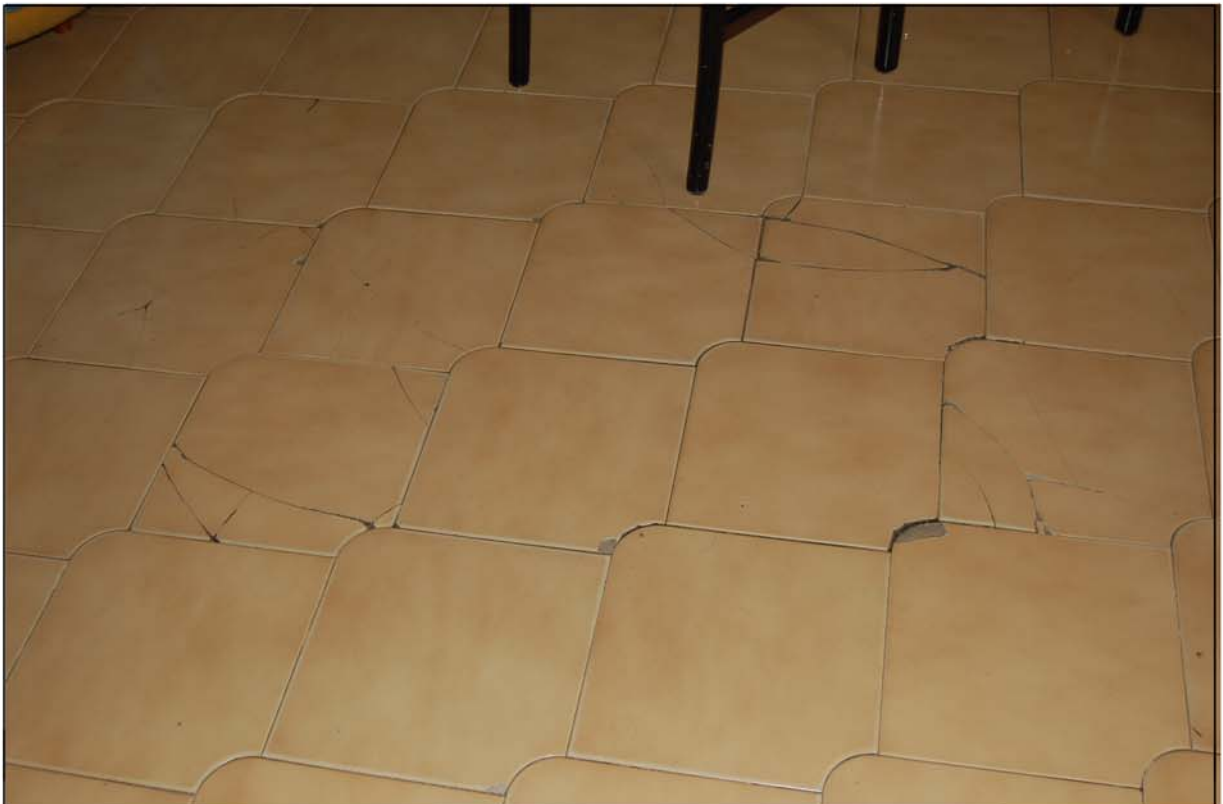
- Foto n°20 - Dettaglio pavimentazione locale soggiorno
