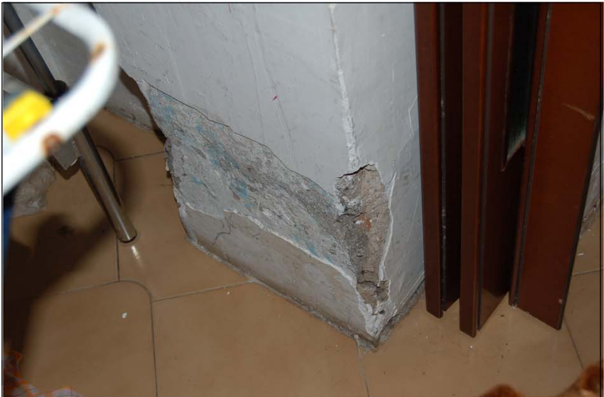
- Foto n°16 - Dettaglio locale cucina
